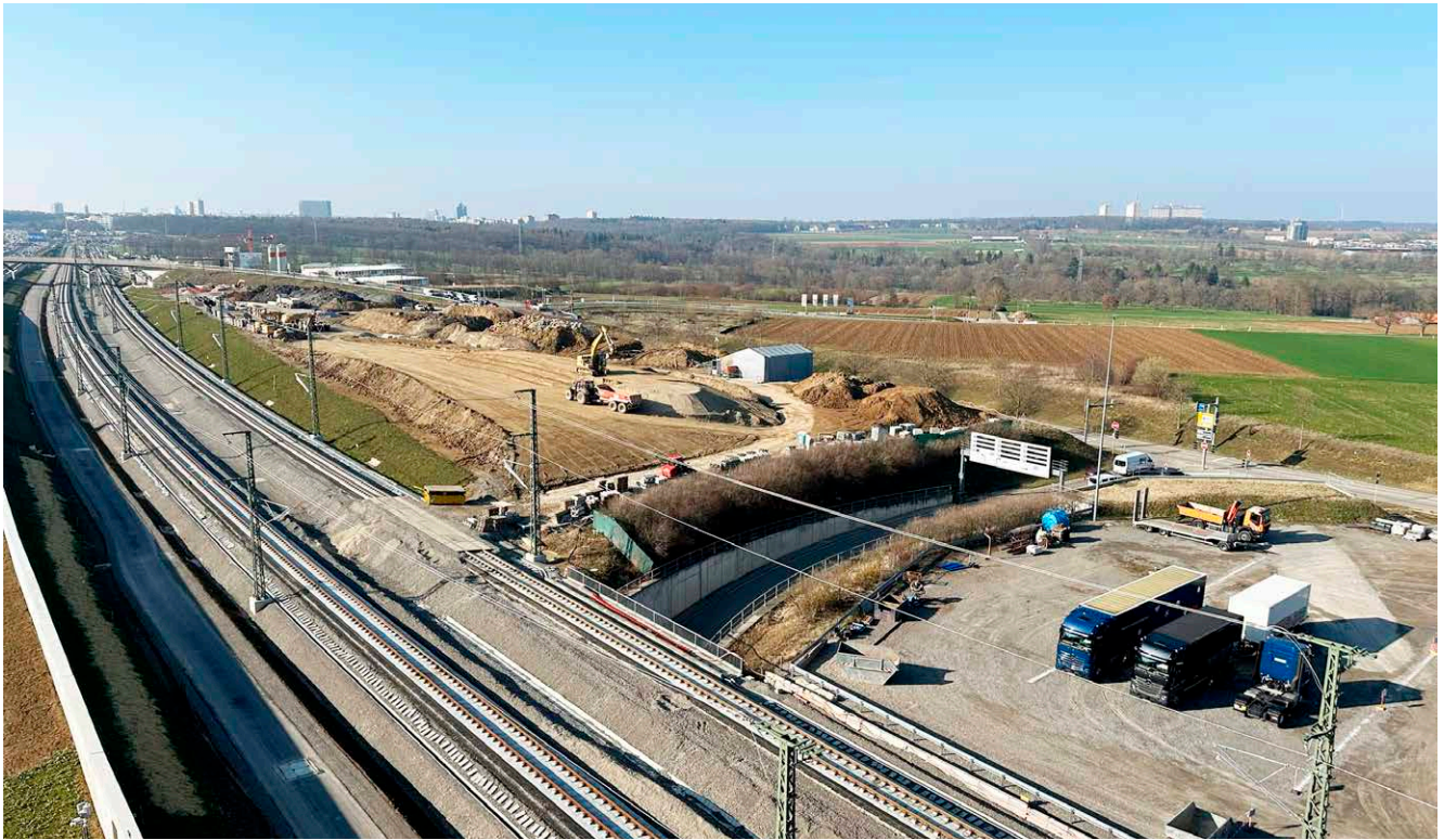
Aus der Luft lassen sich die neu verlegten Gleise gut erkennen.
