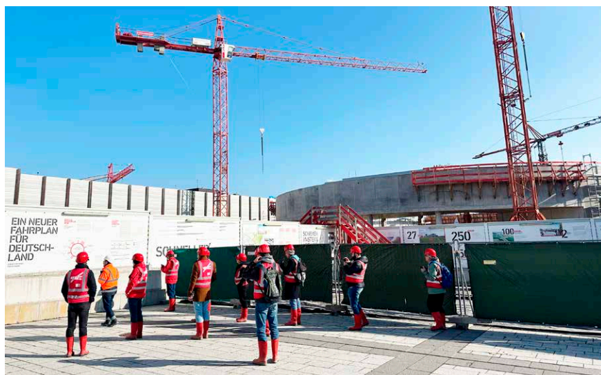
Bis jetzt eine Baustelle: Das neue Zugangsterminal zum Flughafenbahnhof führt in den unterirdisch gelegenen Gleisbereich.
