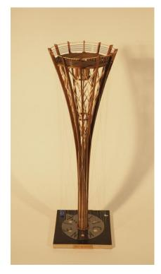
Berücksichtigt man aber die außen liegenden Seilabspannungen, so entsteht ein sinnvolles statisches System, denn die Seile stabilisieren den in ein Stabtragwerk aufgelösten mittleren Teil des Turmes, der einem Sektkelch gleicht. Entstanden ist ein in Erscheinungsbild und Tragverhalten sehr ungewöhnliches Bauwerk.
