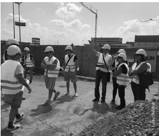
Johannes Ditandy (M.Eng.) zeigte den Studierenden die Baustelle der neuen Deutschlandzentrale von Ernst&Young.
