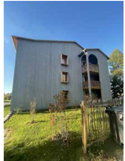
Eigens gefällte und eingeschnittene, durchgängige Fassadenbekleidung im B&O Park in Bad Aibling.
