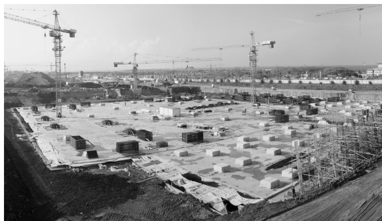
Die Bodenplatten für den Gebetssaal sind bereits gegossen.
