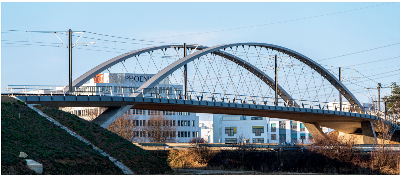
Die Vielfalt und die Leistungsfähigkeit der Ingenieurberufe will Florian Jentsch stärker sichtbar machen. Im Bild: die innovative Stuttgarter Stadtbahnbrücke (Quelle: sbp-Andreas Schnubel)
