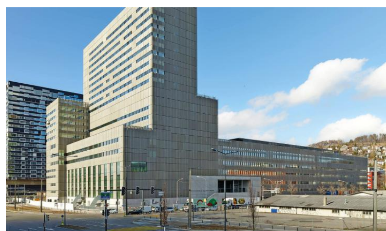
Der Brandschutz für das umgenutzte Toni-Areal in Zürich war aufwendig. FOTO: ALLREAL
