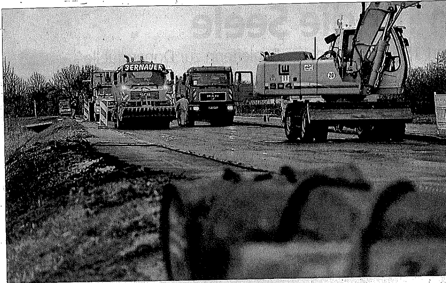
Bauarbeiten im Landkreis Göppingen: Um nicht abgerufene Bundesmittel ist ein heftiger Streit entbrannt. Foto: Giacinto Carlucci
